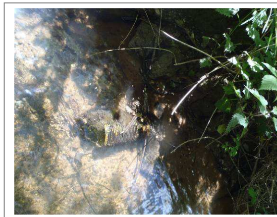
Sortie de drain : effacement du drainage
