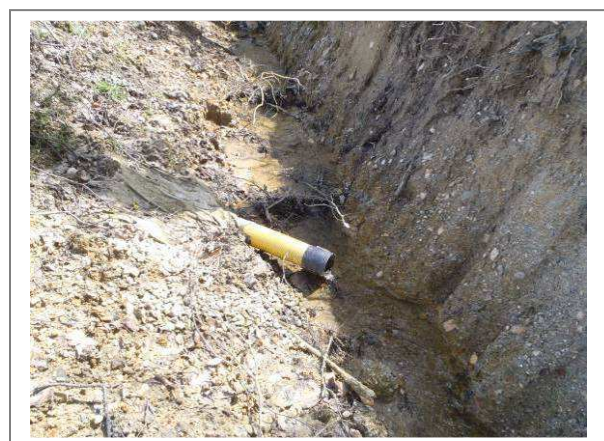
Drainage de zone humide : effacement du drainage
