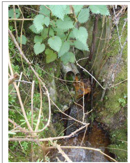
Sortie de drain : effacement du drainage
